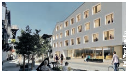
Baubeginn für das Raika-Markthaus ist im März 2024. Das Bestandsgebäude der Bank gegenüber wird künftig die Gemeinde nutzen.
