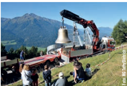
Die Anlieferung und Montage der neuen Glocke.
