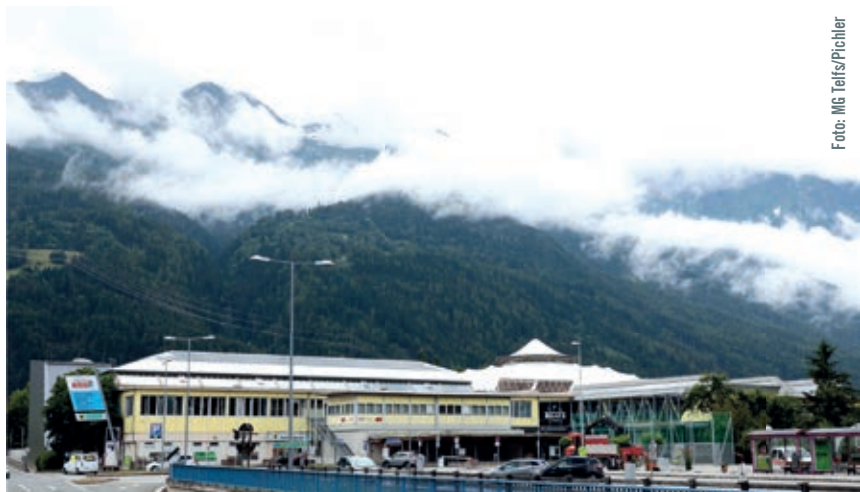
Nach mehr als 20 Jahren werden im Telfer SportZentrum umfangreiche brandschutz- und elektrotechnische Sanierungsarbeiten notwendig. Auch die Dachhaut der Kuppel wird bald »fällig«.
