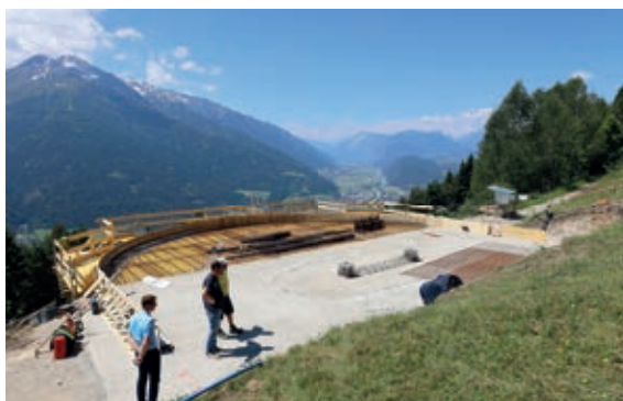
Die neue Aussichtsplattform in Mösern ist bereits fertig betoniert.
