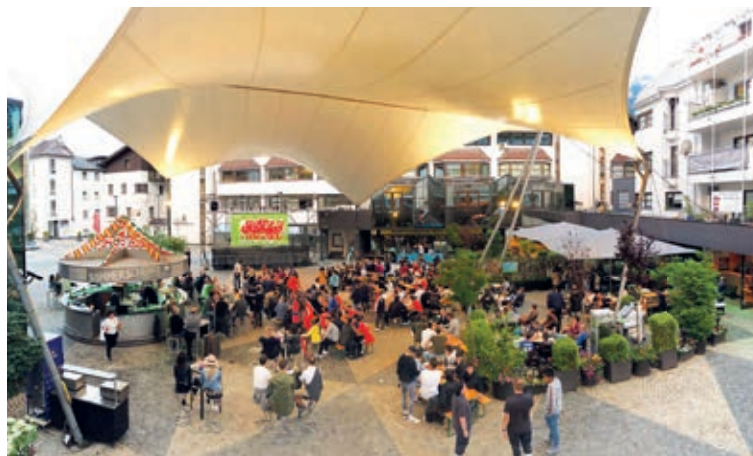
Das Zeltdach über dem Eduard-Wallnöfer-Platz ist seit mehr als 20 Jahren ein Markenzeichen und Garant für Wettersicherheit am Platz auch an sehr heißen oder verregneten Tagen.
