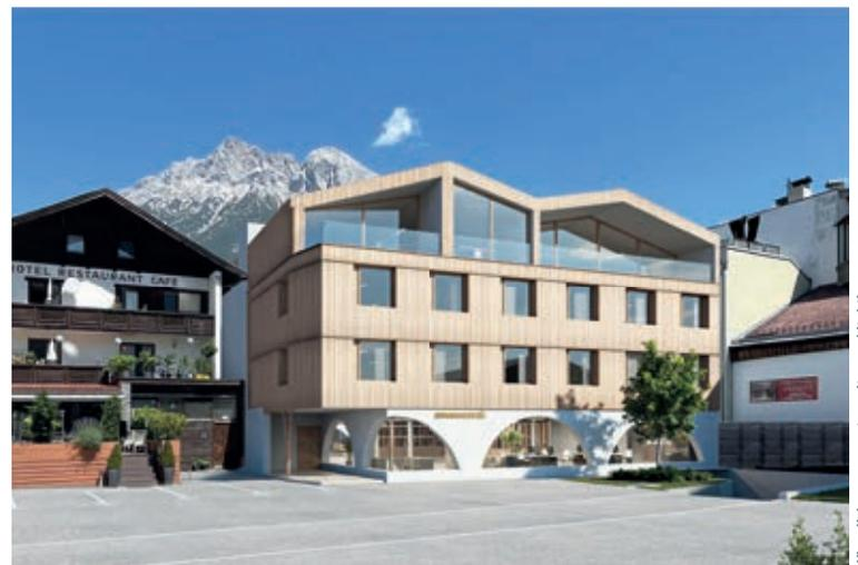
Am Foto oben: Die Nordfassade mit der hölzernen Giebelfassade und dem Durchgang im Erdgeschoss. Unten: Auf der Südseite erhält das Haus eine hinterlüftete Holzfassade. Auch der schmale Durchgang zum Noafnhaus wird erhalten bleiben.
