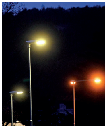
Die Umrüstung auf LED-Lichtpunkte wird nun angesichts der Energiekrise vorgezogen.
