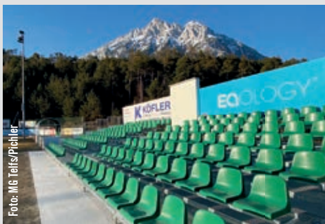
Die neue Tribüne am Sportplatz Emat wird heuer noch überdacht. Auch die Flutlichtanlage kommt neu – mit energiesparender LED-Technik. So auch auf der Tennisanlage am Birkenberg.
