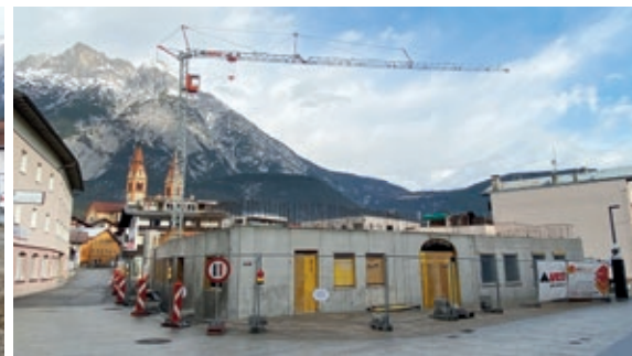
Das Areal des ehemaligen »Dollingerhauses« im Zentrum wird aktuell neu gebaut. Vom Stil her soll der Neubau an den Altbestand anschließen.
