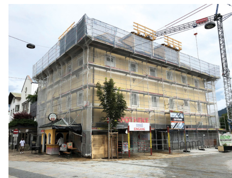
Das »Apothekehaus« bleibt ebenfalls als markantes historisches Gebäude erhalten.
