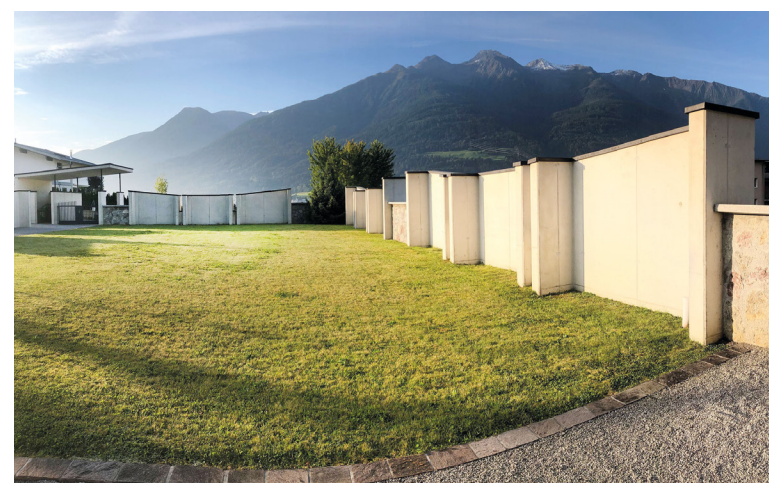
Im südwestlichen Bereich des Friedhofes St. Georgen entstehen in den baulich bereits seit 2010 vorbereiteten Einhausungen gesamt 81 neue Urnennischen.
