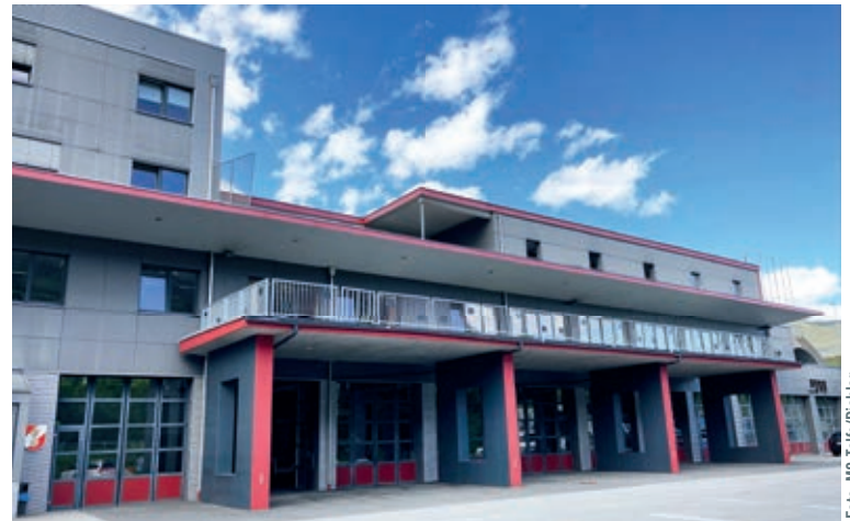
Die neuen Wandscheiben vor der Feuerwehrrhalle sind die sichtbarsten baulichen Maßnahmen zur statischen Ertüchtigung des Gebäudes. Dieses ist seit Herbst 2019 wieder zur Gänze »safe«.
