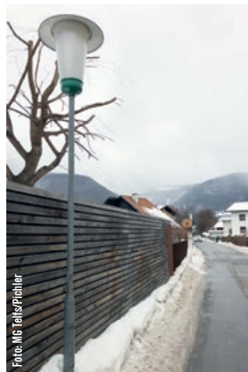
Die alten Laternen werden gegen energiesparende LED-Lampenköpfe getauscht.
