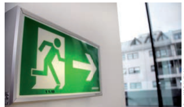
Die Kontrolle der Fluchtwegsicherung ist ein Teil der Feuerbeschau.
