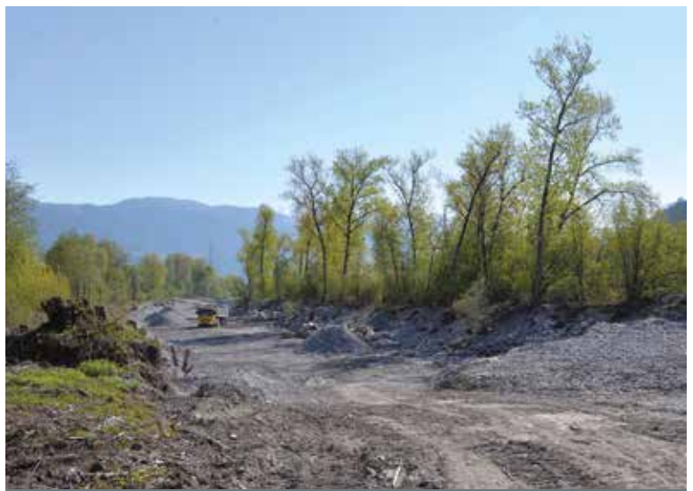
Im Herbst werden die Bauarbeiten für den Inn-Seitenarm fortgesetzt. Foto: Dietrich
