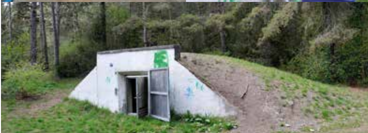
BMStr. Ing. Martin Riedl zeigt den alten Speicher Puelacherweg. Fotos: Dietrich
