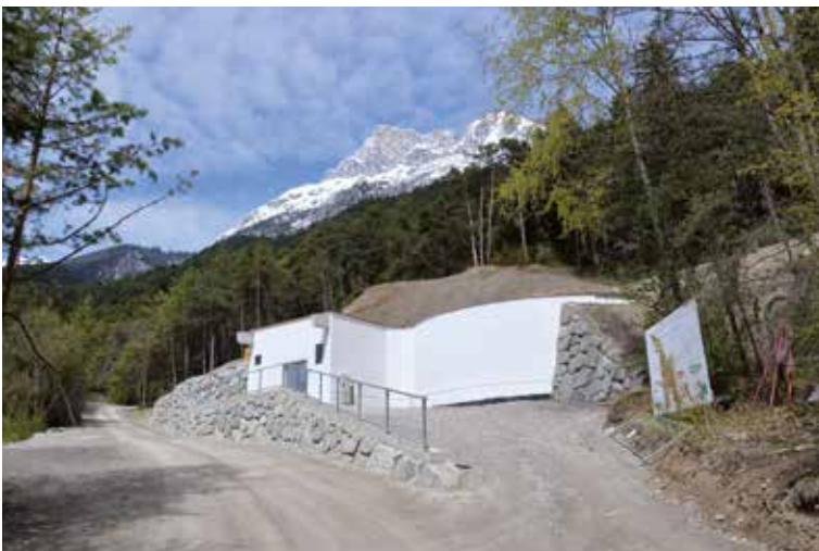
Der neue Hochbehälter Dandl 2 fasst 1500 Kubikmeter Wasser.
